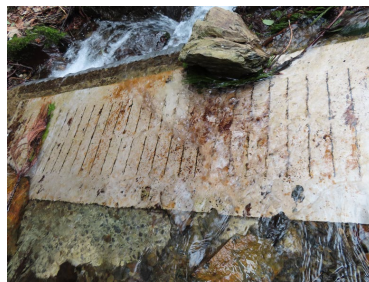
写真2 大吉寺 スクリーンと原水槽
