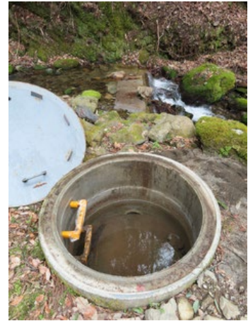
写真 1 大吉寺供給水の原水である溪流と原水槽
