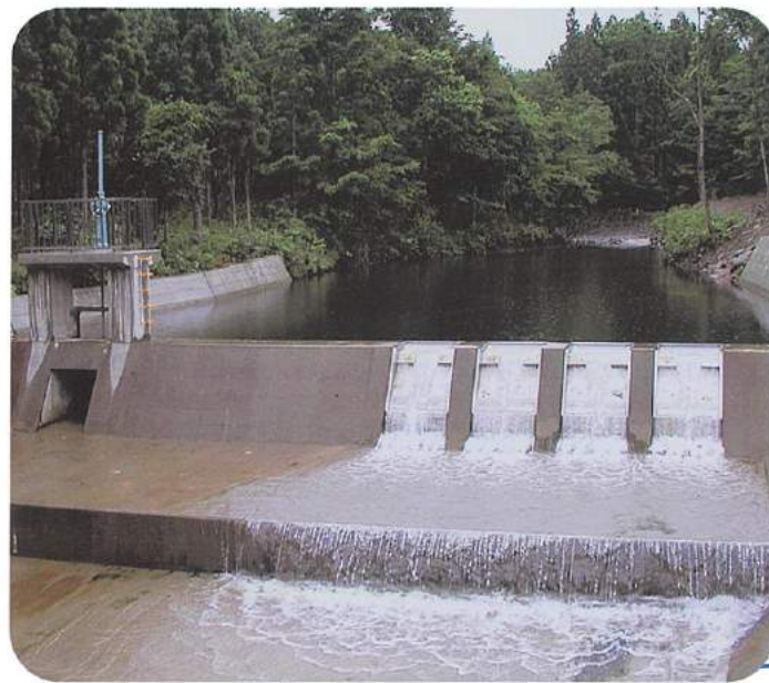
青森県内 7型 4台 取水量6000 m 3 /日
