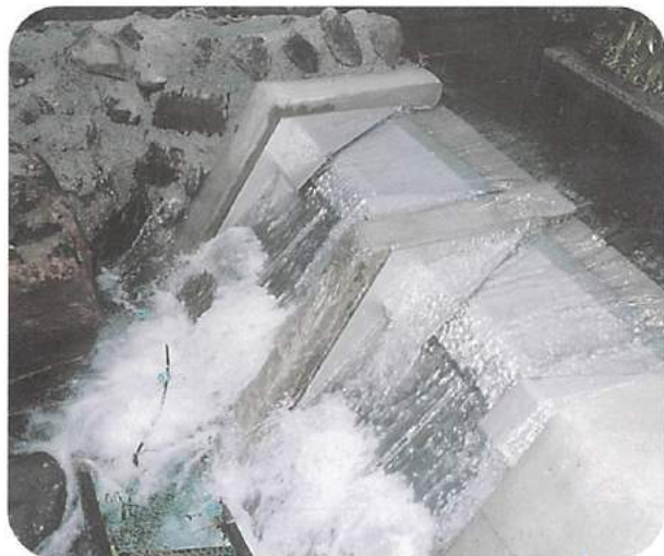
鹿児島県内 6型 2台 取水量2000 m 3 /日
