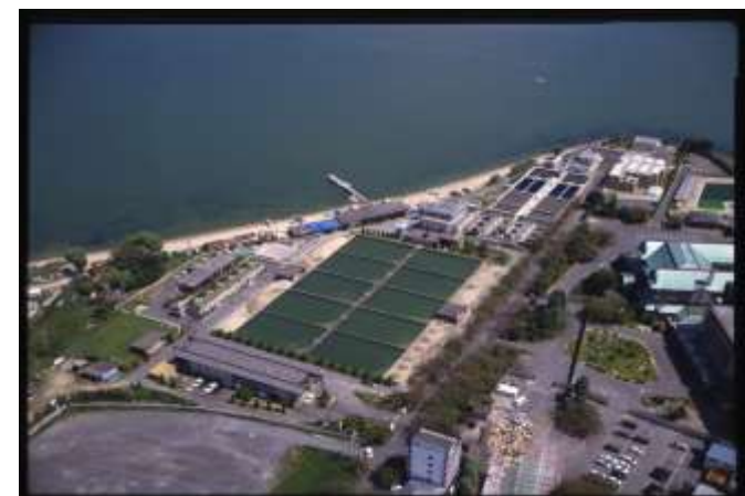
大津市柳が崎浄水場
