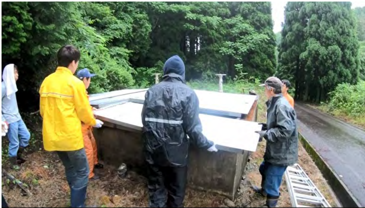
ろ過池の清掃作業（T県N飲供）
