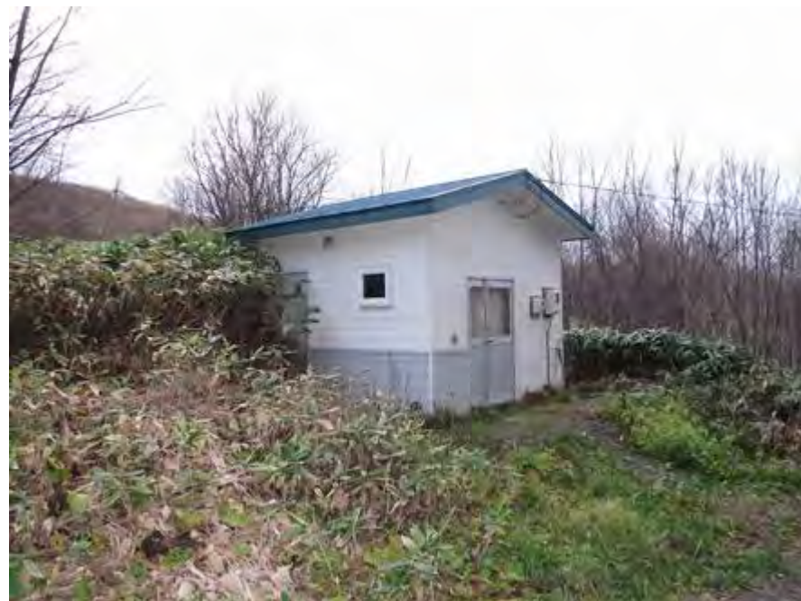
浄水処理施設 急速ろ過＋塩素
