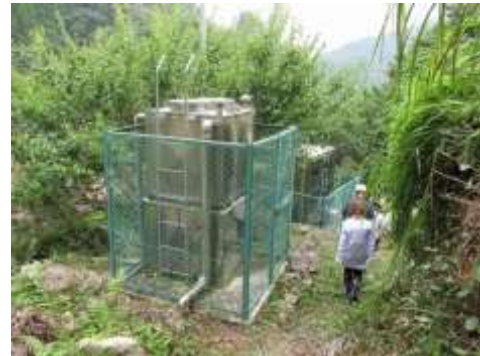
写真8 沈砂池と配水池
