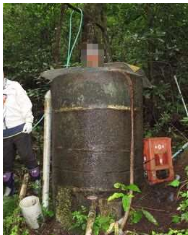
写真3 富厚里中組山水会 沈砂池
