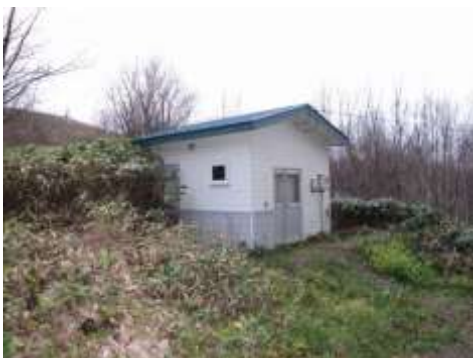
写真 15 西麓郷専用水道 浄水処理施設
