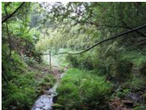
写真4 浄水施設までの導水管
