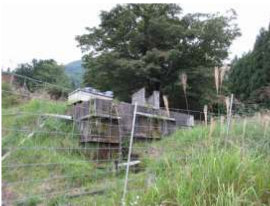
写真12 貯水槽（配水池）
