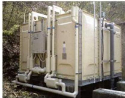
無動力式除砂装置 + 原水槽
