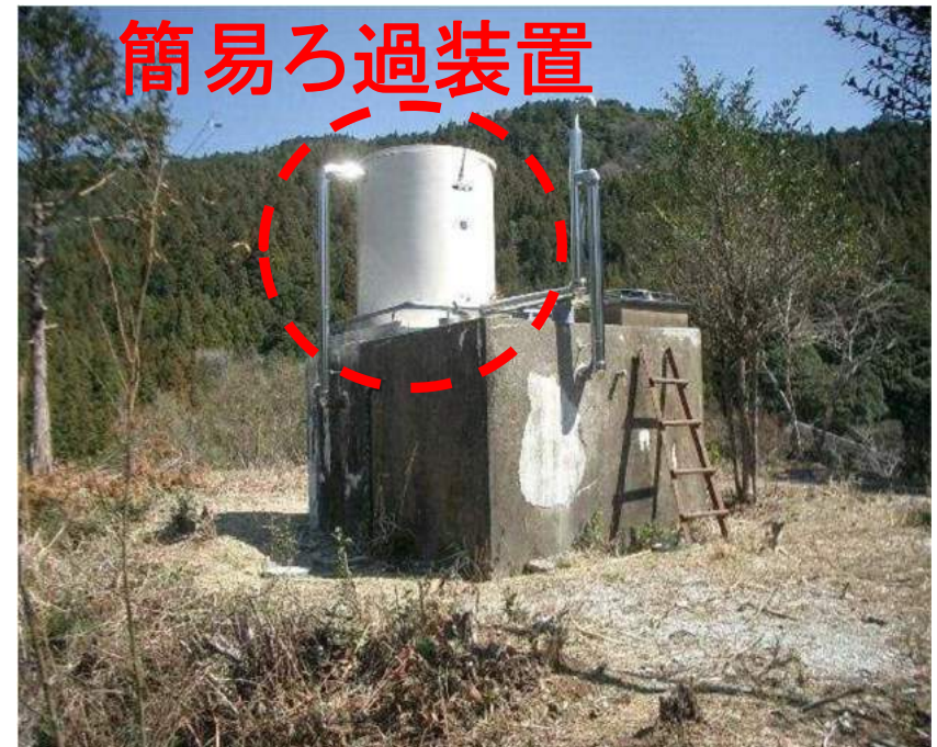
配水池天端に設置した 簡易ろ過装置
