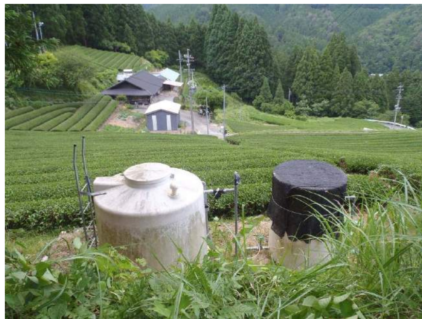
住居の上に設置された施設
