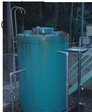
浄水(上向式緩速ろ過)
