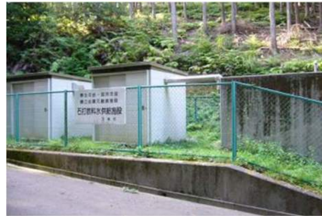
浄水(急速ろ過) 配水池(RC製)
