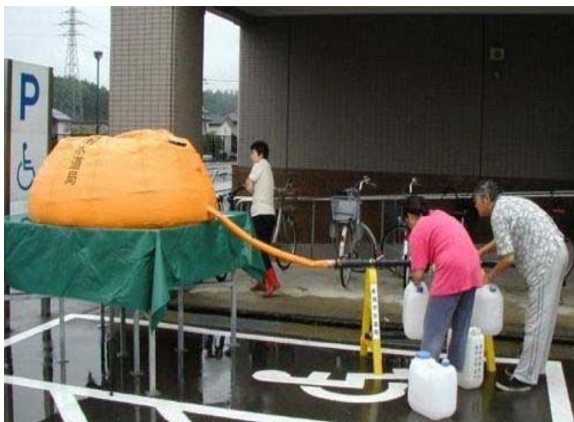
写真 11 仮設水槽（バルーン型）による応急給水（出典：新潟市水道局ホームページ）
