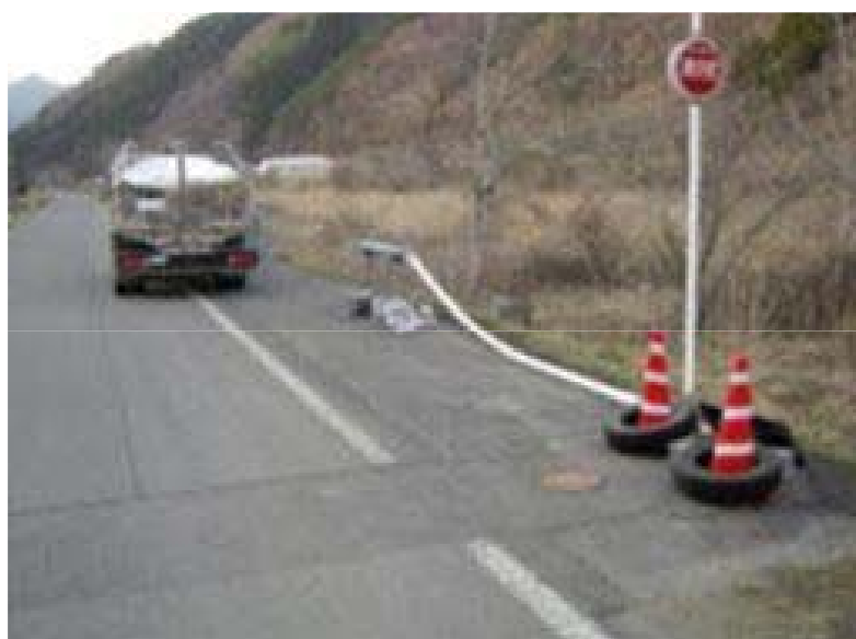
写真7 仮設給水栓（避難所近く）（出典：神戸市水道局ホームページ）
