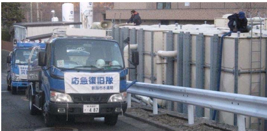
写真5 加圧ポンプ付きの給水車による医療機関等の受水槽への給水（出典：新潟市水道局ホームページ）
