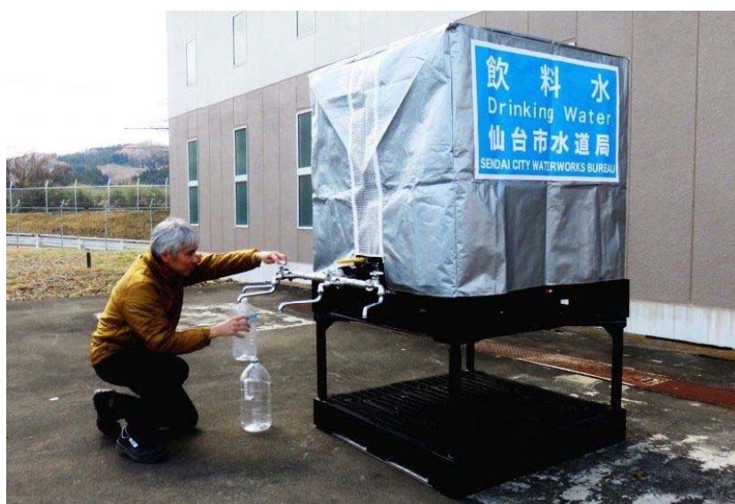
写真 12 仮設水槽（タンク型）による応急給水（写真提供：仙台市水道局）
