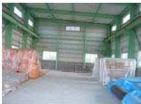
写真 21 共用備蓄倉庫内観（出典：写真 20 と同じ）
