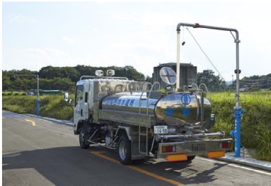
写真 18 給水車への水の補給設備（写真提供： 仙台市水道局）
