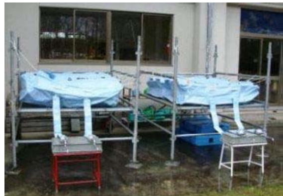
写真10 避難者が多い学校に給水バグの給水拠点を2基設置（出典：（公社）日本水道協会岩手県支部「東日本大震災における応急給水活動等の記録」（2012年12月5日増訂））
