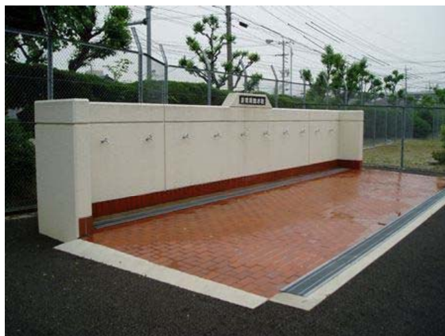
写真3 常設給水栓（出典：名古屋市上下水道局ホームページ）
