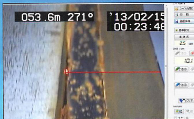
ダクタイル鋳鉄管継手部状況
