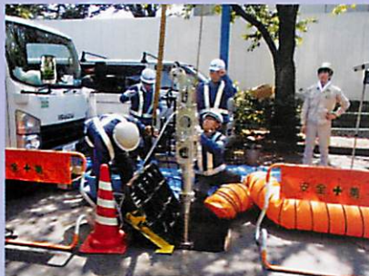
設置作業状況
