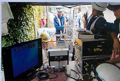
水中ロボット制御状況
