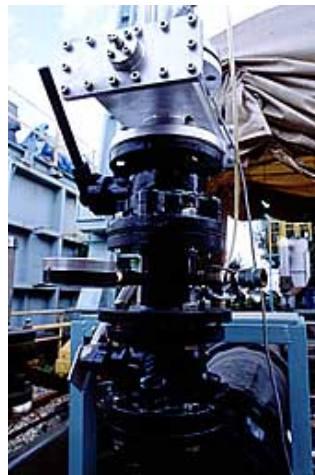
消火栓などが取り付けられているT字管にロボット挿入・回収装置が連結される
