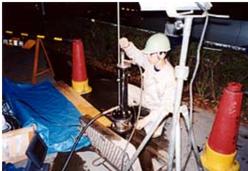
実管路での管内調査
