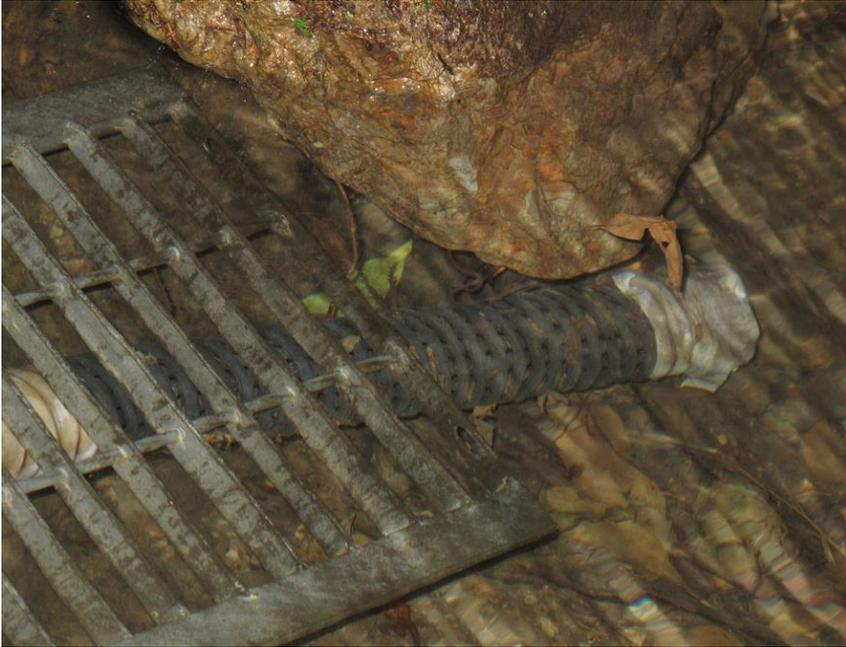
渓流水の取水施設(ポリ管。先端には蓋が取り付けられており、側面が多孔構造になっているもの)
