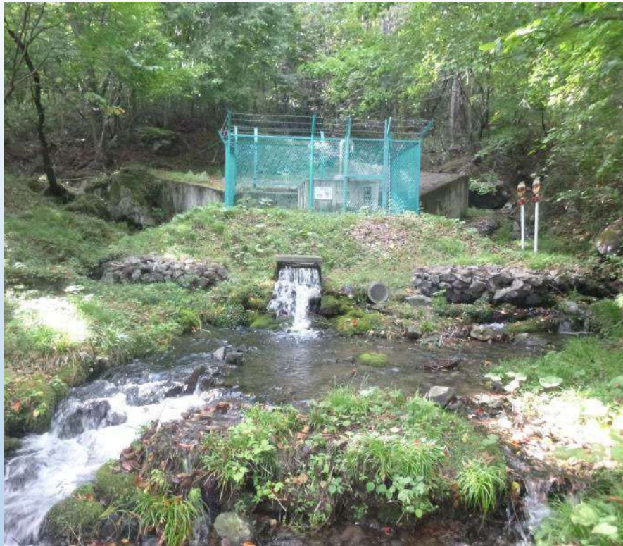
水源の外観(湧水)
