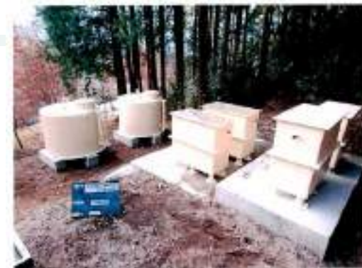
FRP製システム、給水対象：7戸、4t/日の例
