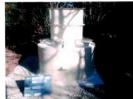
一体型FRP製システム、給水対象：1戸、2t/日の例
