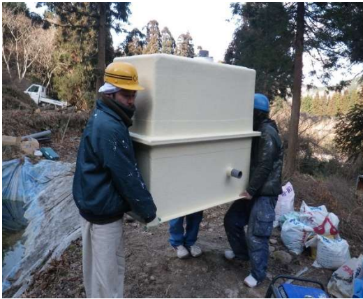
図 64 FRP 製ろ過ユニット設置状況
