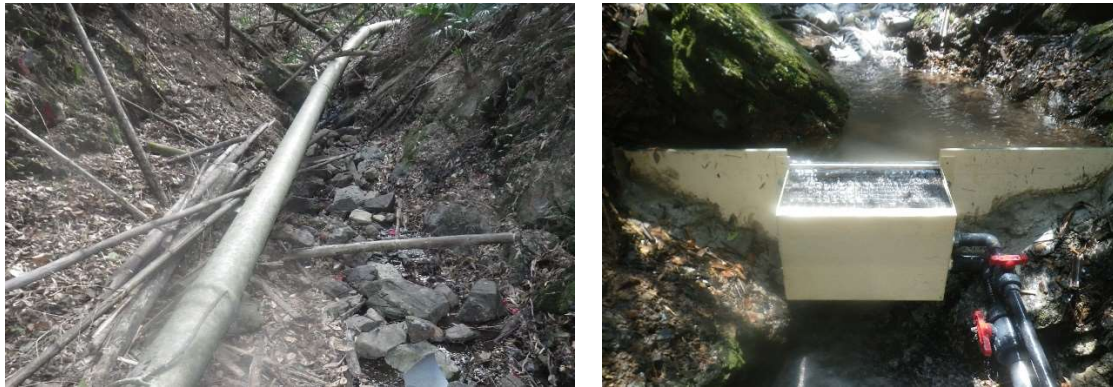
図 67 工事困難な場所での設置例（左図：着工前，右図：完成後）
