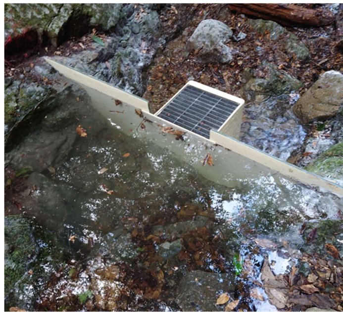
図 66 FRP 取水堰・集水弁設置事例（大分市 K 地区）
