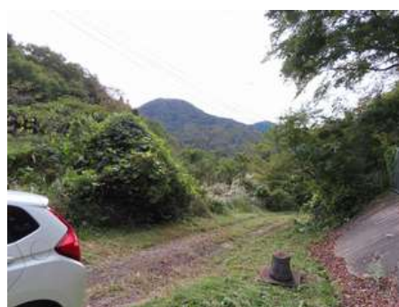
写真 26 竹之尾旧飲料水供給施設 配水方向
