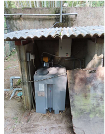
写真 1 塩素貯留槽
