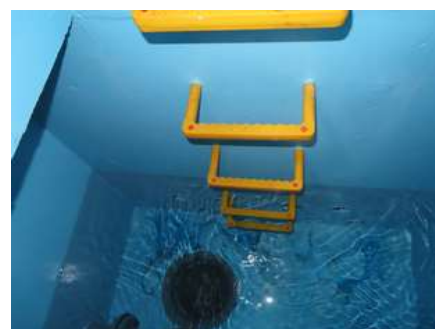
写真 24 取水柵内部 壁面に集水管からの流入口が見える。下部に見えるのは排泥管。
