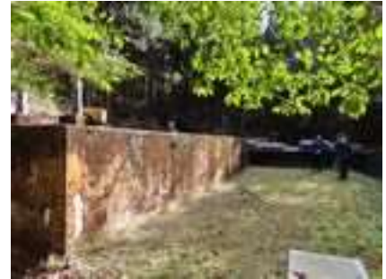
写真 9 振草浄水場 手前が普通沈殿池、奥が覆蓋 付き緩速ろ過池
