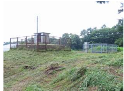
写真 21 新設水源である深井戸
