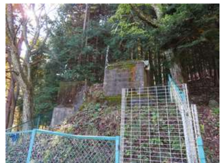
写真 4 大仏飲料水供給施設 3 つ目最古の配水池
