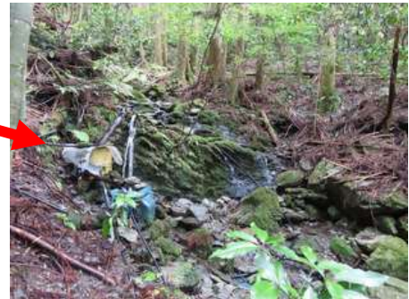
写真13 水源地と取水桝
