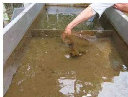
写真17 逆流洗浄前のろ過槽の様子
