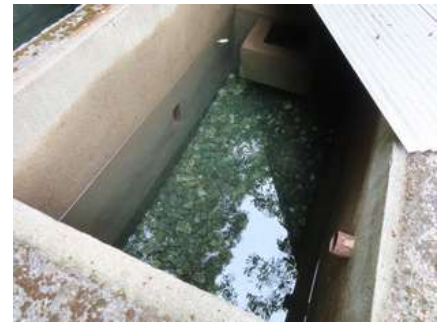
写真 20 ろ過砂が撤去されたろ過槽
