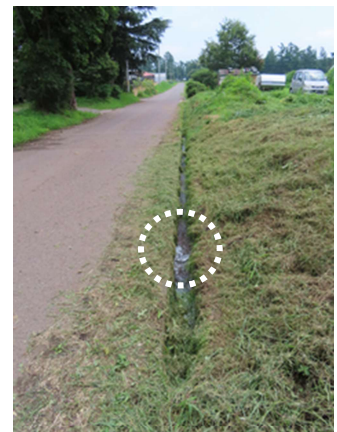
写真 22 水ポンプ作動時の配水池からのオーバーフロー
