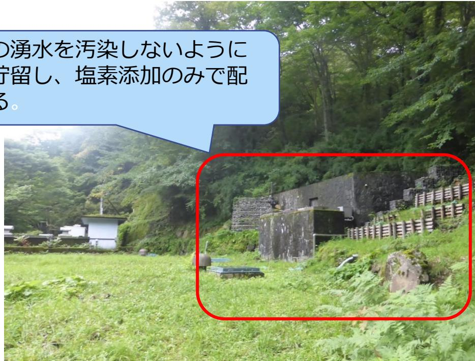
水道水源が表流水である場合、小規模であっても浄水施設が必要となる。良質な地下水や湧水が地域に存在する場合、それらを活用し、水源で原水が汚染しないようにすることによって、浄水処理・維持管理も最小限にすることが可能である。
