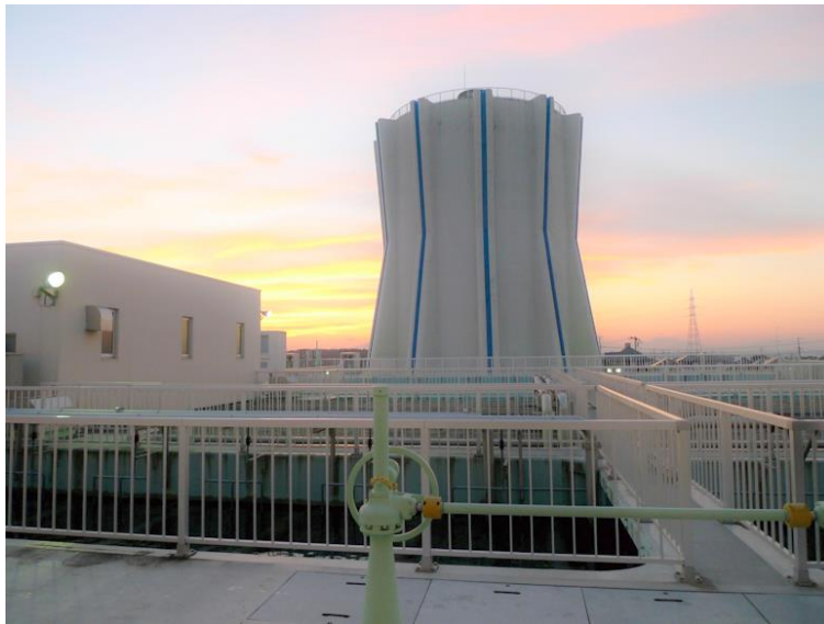
白山浄水場内配水塔 八戸圏域水道企業団
